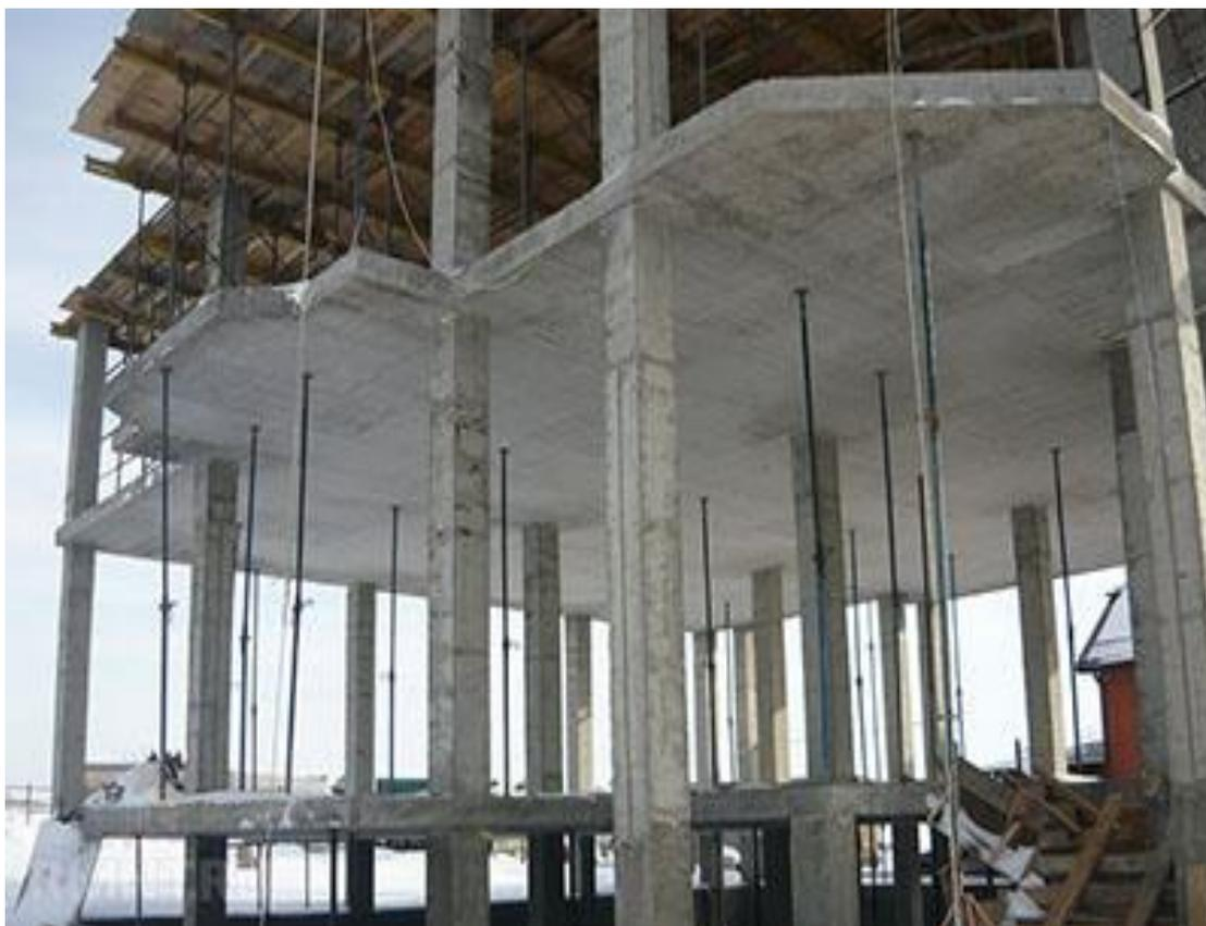
Рисунок 1.1 - Конструкция монолитного безбалочного перекрытия
