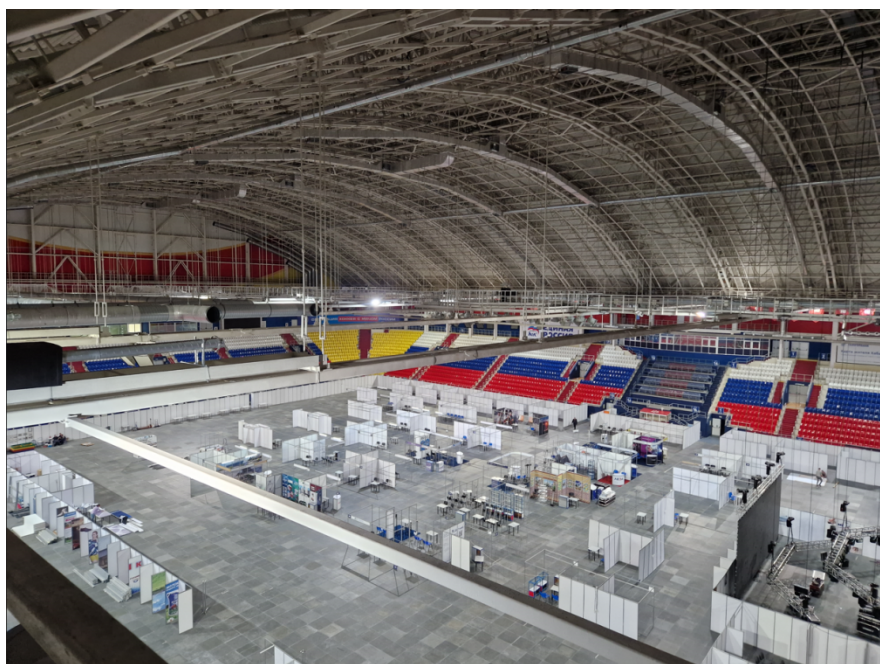
Рисунок 3 – Металлический каркас здания Арены «Ерофей»
