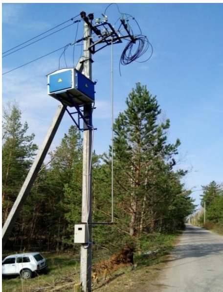
Рисунок 3 - Установка ПКУ на границе балансовой принадлежности
