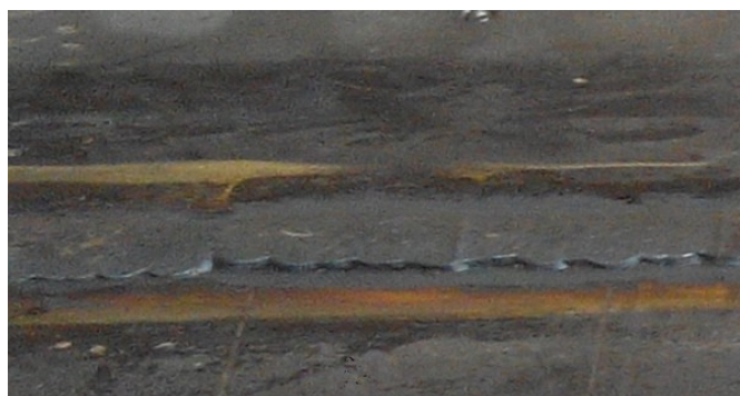
Рисунок 10 – Сформированный на подкладках шов.
