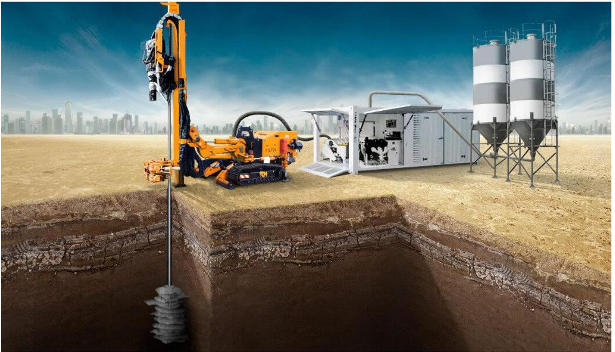
Рисунок 3.4 – Процесс усиления грунтового слоя цементацией.
