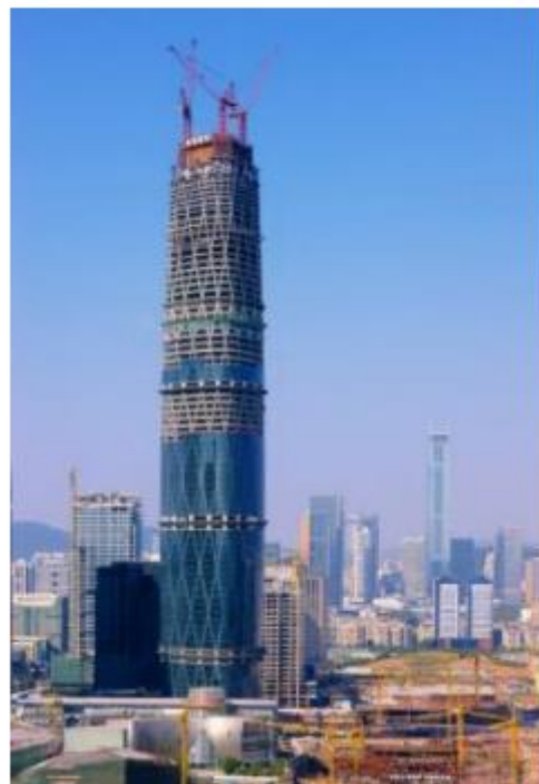
Рисунок 5 Строительство башни «Guangzhou International Finance Center»
