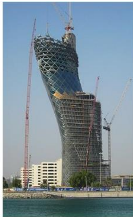
Рисунок 3 Строительство башни «Capital Gate» Alfabuild
